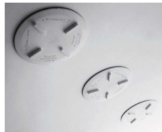
Usos ingeniosos para tapas de tinaco: registros para instalaciones en plafón.
